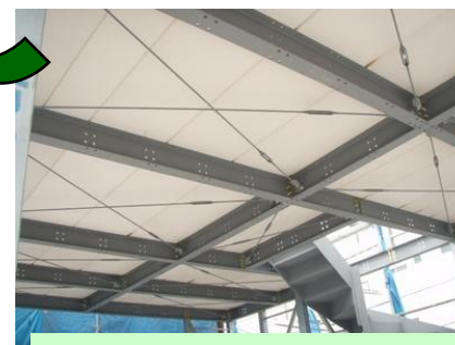
水平ブレースを用いた ALCパネル床版の例
