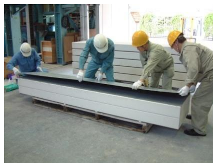
鋼板の貼付け
