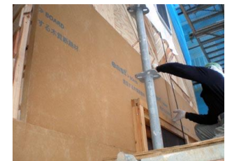
実代による施工検証
