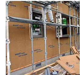
実代施工状況
