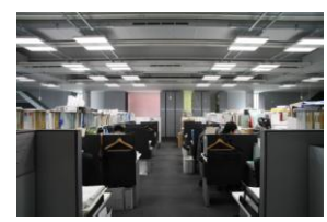
LED照明器具設置状況
