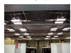
パーソナル吹出口設置状況
