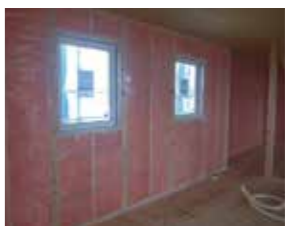
しっかりと、隙間なく配置された断熱材で第一の要望である「暖かい家」を実現しています。
