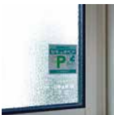
小さな開口部でも、防犯を疎かにしてはならない。細かい配慮が行き届いています。
