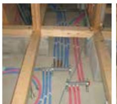
効率的な集中配管。点検もしやすく、万が一トラブルが起きてもすぐに対応できる構造です。
