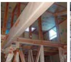
断熱材施工状況。ゼロエネ住宅への関心が高いだけあって温熱環境も最高の等級4を獲得。
