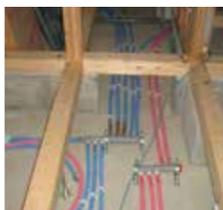
効率的な集中配管。点検もしやすく、万が一トラブルが起きてもすぐに対応できる構造です。
