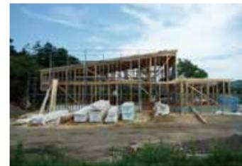
「構造の安定性」の評価は等級2。建築基準法で定められた性能の約1.25倍の強さを持ちます。「住宅性能表示制度」を活用したことにより、家の性能がわかりやすくなりました。
