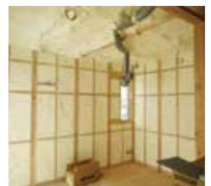
断熱施工を隙間なく埋められた壁。温熱環境は最高の等級4。吹き抜け空間を活かすための、確かな性能の裏付けです。
