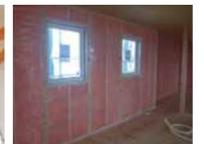
しっかりと、隙間なく配置された断熱材で第一の要望である「暖かい家」を実現しています。
