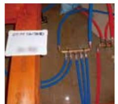
施工時の、集中配管の記録。すっきり整えられており、「維持管理・更新への配慮」の高さを窺わせます。
