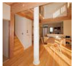
リビング中央部の「立ち下がりがダクト」を通じて、取り込んだ熱が床下に送られます。
