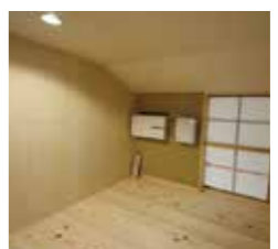
ロフト階に太陽光発電の室内盤。モニターを任意の場所に設置することもできます。
