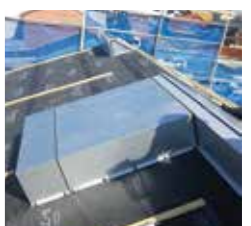
太陽熱利用システムを設置。ゼロエネルギー住宅は運用コストの面でも大変魅力的です。
