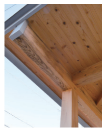
しっかりした施工・設計
