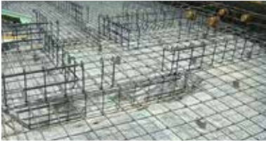
多量の配筋を敷くことで頑丈な基礎を作る
