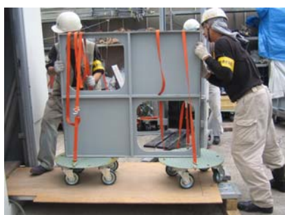
ユニットによる搬入で大型重機を必要としない
