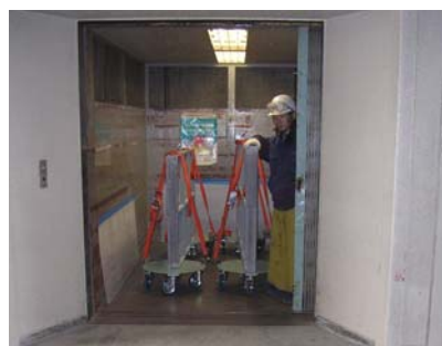
既存エレベータでの搬入
